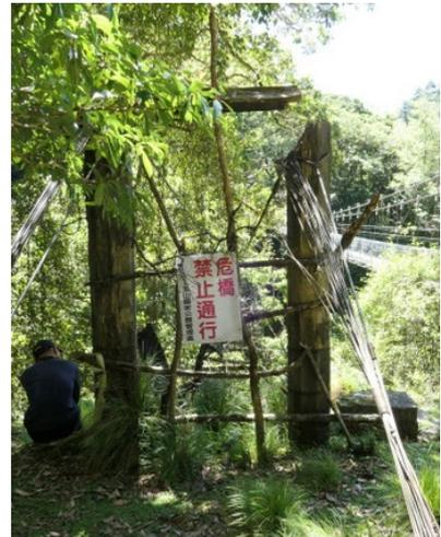
左為 2006 年意西拉鐵線橋南側橋門外觀，右為 2017 年橫梁斷裂、主索脫落之情形
