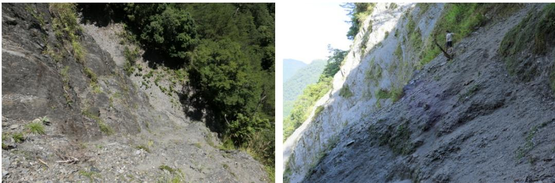
南側大崩塌調查照片，左為崩塌南側，右為崩塌北側，岩壁垂直陡峭無法通行，阻斷的直線距離約為 55 公尺
