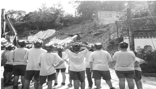
圖 1 學生目睹土石流嚴重破壞學校建築
